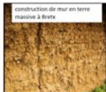
Mur intérieur : 1 m d'épaisseur à Bretx
